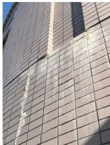
施工中、施工後、気温が3度以下に下がる可能性がある場合、施工してはいけない事になっています。また、接着するモルタルも練ってから1時間以内にタイルの接着に使わなければなりません。こうした事がなんらかの理由により守られていないと、あとで接着力不足で剥がれたり、浮いたりしてきます。それは最初の大規模修繕の調査の時期、およそ完成後10年から12年くらいだったころの調査によってはじめてわかることです。（新築マンションを買ってはいけない理由のひとつ、欠陥マンションがわからない）修繕積立金の額は跳ね上がり、住民の家計を圧迫するようになります。こうした施工不良がある物件は、他の部分も施行不良である可能性があります。タイル貼り替え箇所の多いマンションは「買つてはいけない」マンションです。
